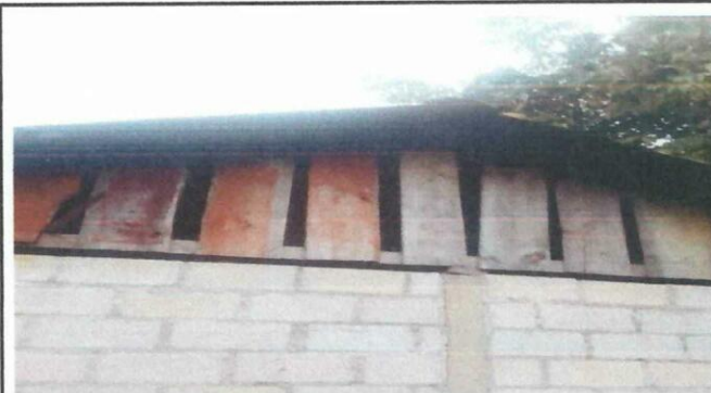
Foto 4: CAMBIO DE ENTECHADO DE LA COCINA
