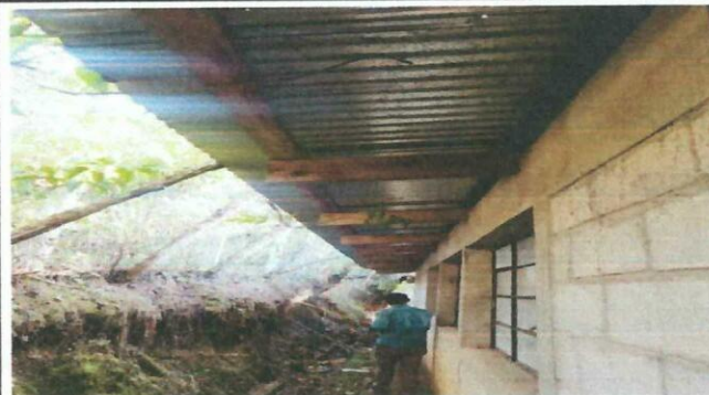
Foto 2: CERCO O MURO PERIMETRAL
