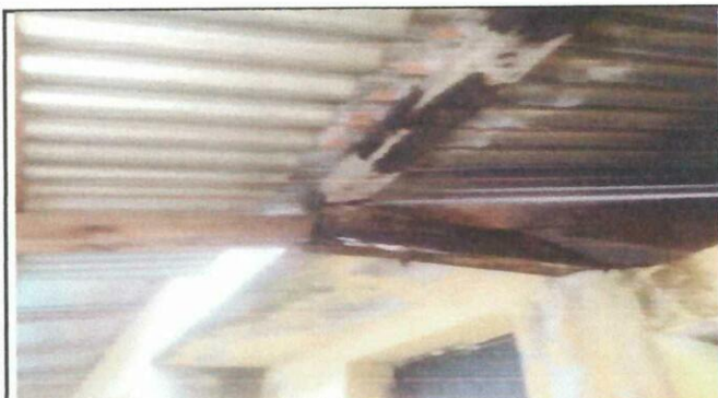
Foto 5: CAMBIO DE VIGAS DE MADERA POR COSTANERAS
